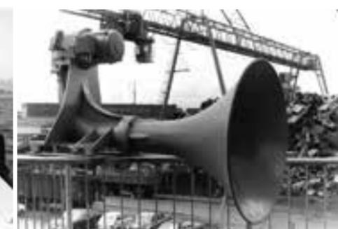
1972 Zet Horn 90AC zum Einsatz auf Schiffen der Schiffsklasse I // Zet Horn 90AC for use on ships of ship classe I.
